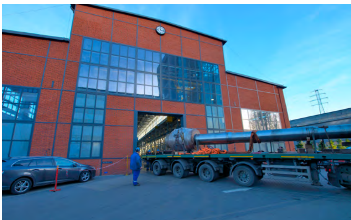
Zmodernizowana hala Wydziału Siłowni Okrętowych w Remontowej SA. Fot.: Remontowa SA
