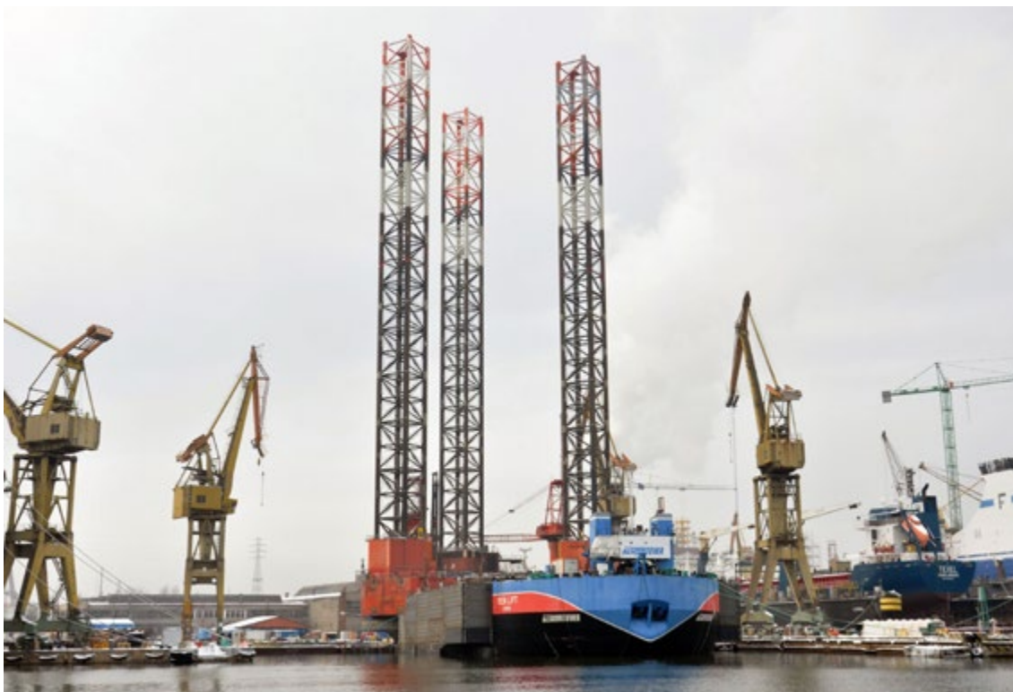
Platforma Petrobaltic zadokowana na pokładzie Rem Lifta 25 000 Fot.: Jerzy Uklejewski
